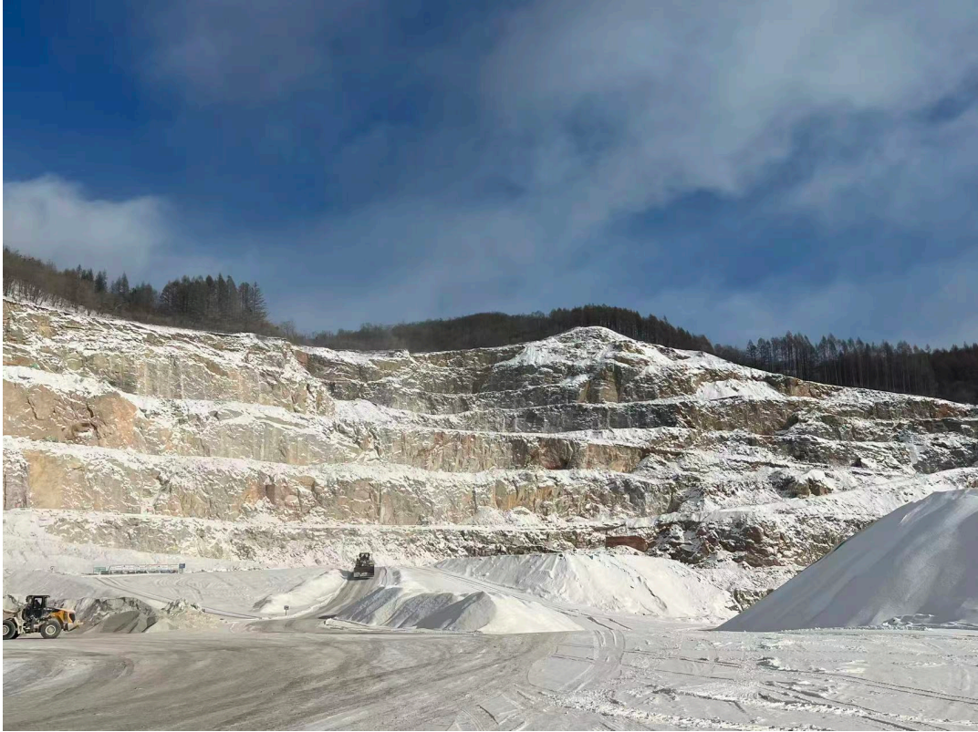
图 3-1 露天采场局部现状照片
