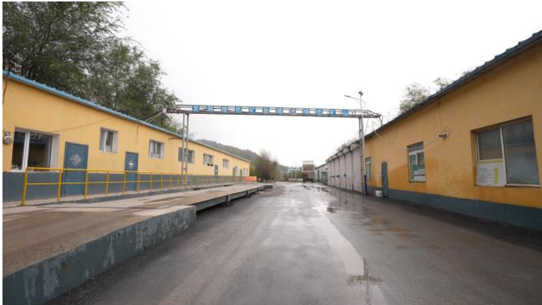
图 3-2 办公区局部现状照片
